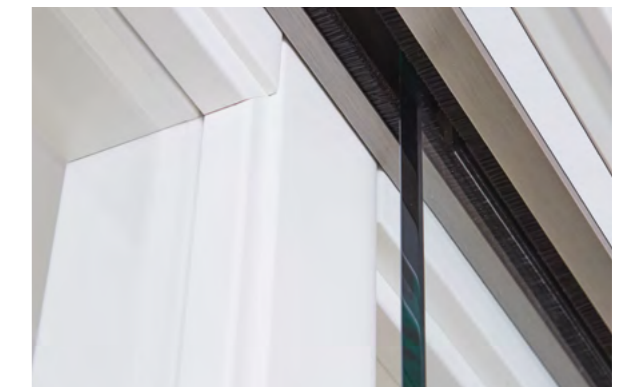
Befestigung einer Ganzglastür im Schiebetürbeschlag SLIM-Inlay
